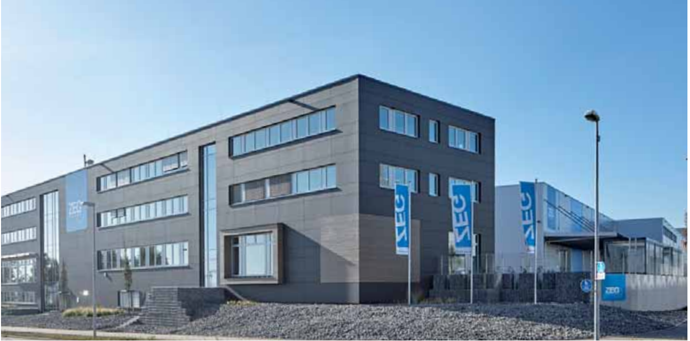
ZEG Zentraleinkauf Holz + Kunststoff eG, Neubau Niederlassung Kornwestheim
