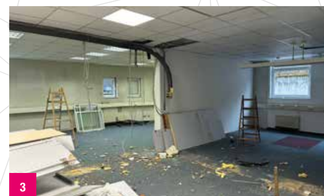
Bilder 1 bis 3 während der Umbauphase
