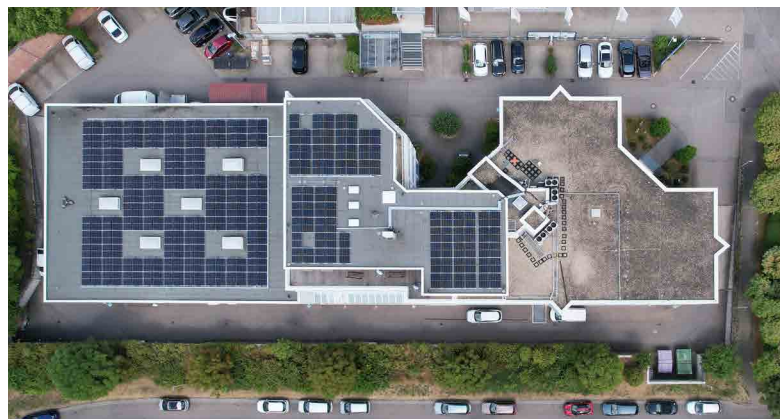
Photovoltaikanlage auf dem Firmengebäude
